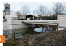
Pont en béton précontraint - BP
