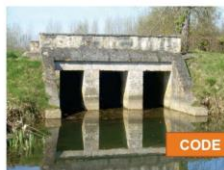
Pont dalle en maçonnerie dit « dalot » - MA(D)
